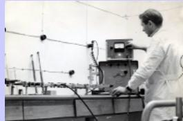
Goliardo Tomassetti misura le caratteristiche dei ricevitori per la Croce del Nord nei laboratori dell'Istituto di Fisica della Università di Bologna.
