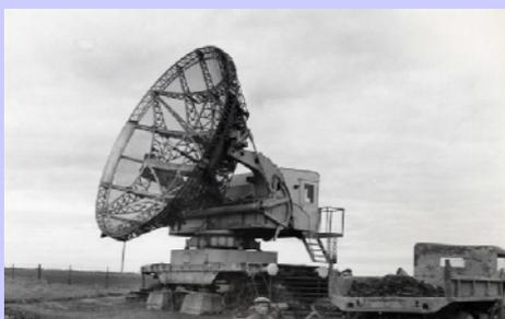
Nell'immediato dopoguerra vengono utilizzate le antenne di 7,5 m Wurzburg dei radar tedeschi per costruire i primi radiotelescopi.
